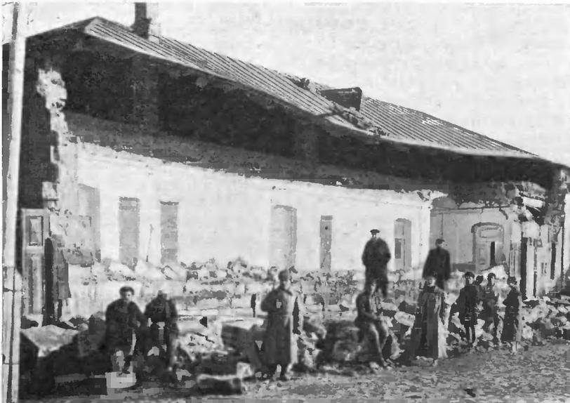
Рис. 4. Разрушенная западная стена здания детского приюта в Лениканане.
